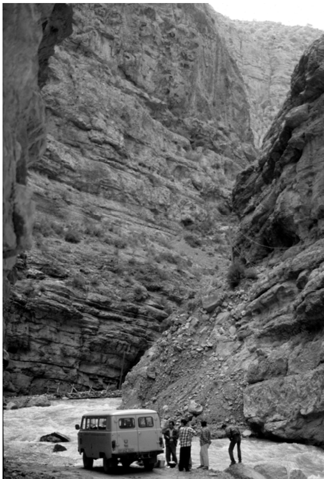
Рис. 5. Ущелье Шерабад-дарьи к северу от Дербента: дорога, размытая весенним паводком с остатками каркаса из стволов деревьев, образующего опору для наброса из камней (май 1997, вид с юга).
