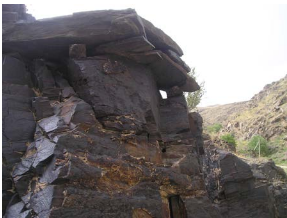
Рис. 9. Возведение навеса над аварийной плоскостью.
