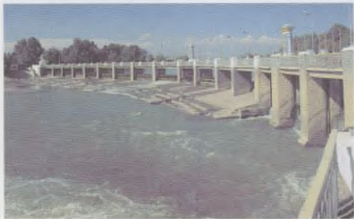
Гидросооружение Ферганского канала.
