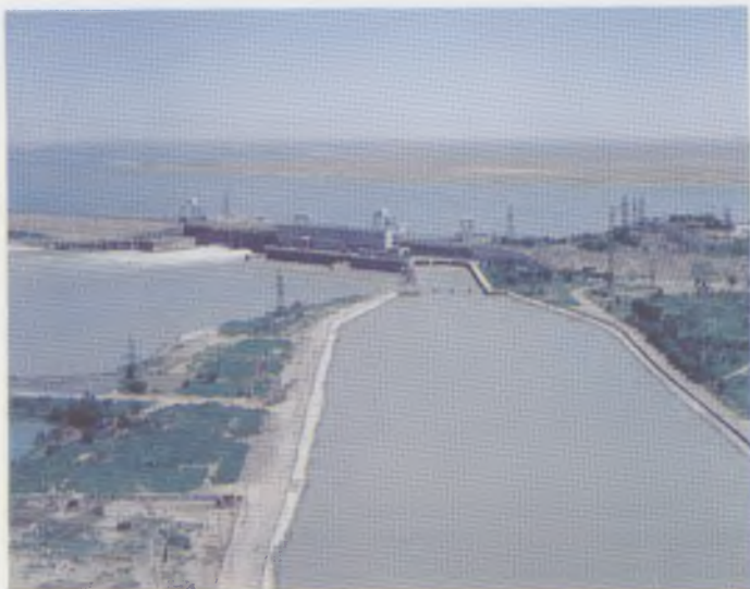
Отводной канал Тюмююнской ГЭС.
