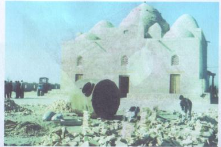
Масжиднинг таъмирланиш жараёни (2006) Реставрационный процесс мечети (2006) The restoration process of the mosque (2006)
