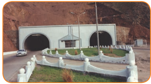
74-nji surat. Kamçyk geçelgesindäki tonnel.
