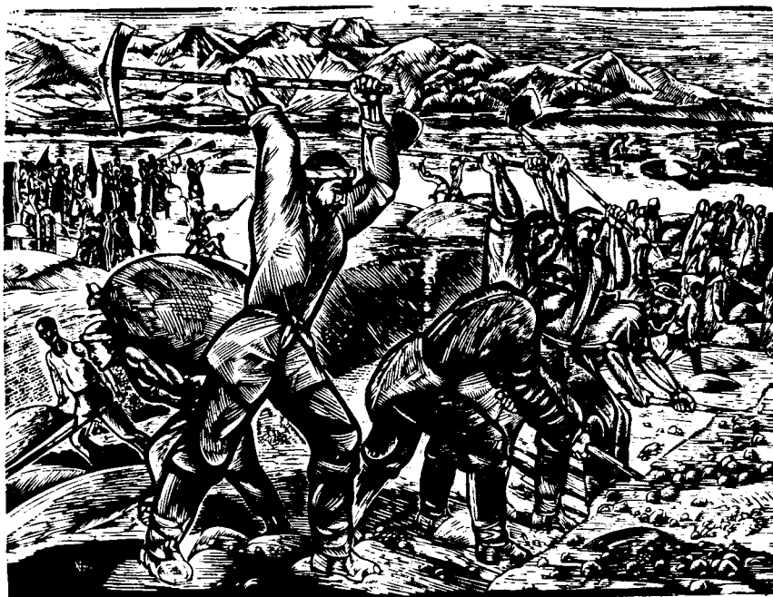
КАТТА ФАРҒОНА КАНАЛИ ҚУРИЛИШИДА
